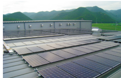
太陽光パネルの設置(岡山和気ヤクルト工場)
