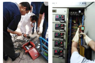
上海工場の電気安全自主検査
