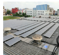
ソーラーパネル工事
