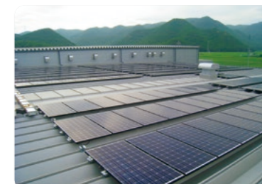
太陽光パネルの設置(岡山和気ヤクルト工場)
