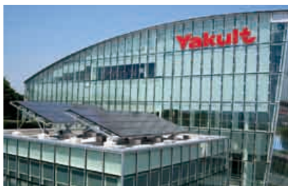
増設した太陽光発電システム
